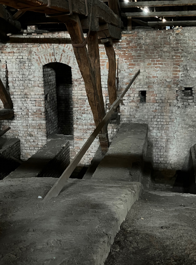
Costolone della volta con tirante metallico (14.04.2022)
